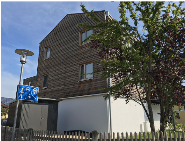
Abbildung 3 Angepasste Bauweise ohne Wohnnutzung im Erdgeschoss
