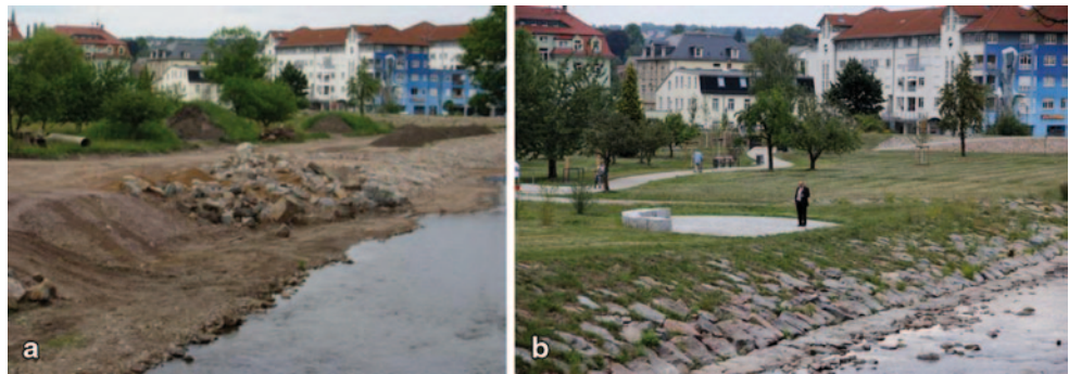
Abb. 2 a und b Stadtpark und Hochwasserschutzanlage: Der Windberg-Park in Freital im Bau und nach der Fertigstellung (Fotos: a S. Rößler, b Landschaftsarchitektur Frase, Dresden)
