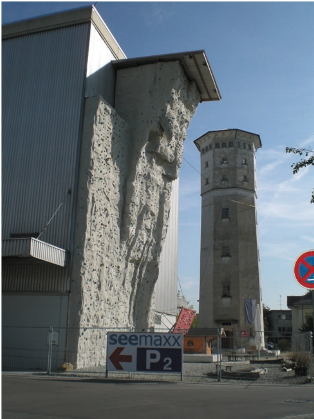
Abb. 5 Der ehemalige Wasserturm am Rande des Schiesser-Areals. (Foto: Anja Lassel)
